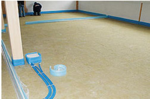
Homogene, widerstandsfähige Dämmplatte für erhöhte mechanische Belastungen unter schwimmenden Unterlagsböden.
